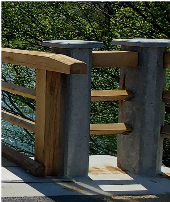
(Zaključki ograde na mostu v Cerkljah ob Krki)
